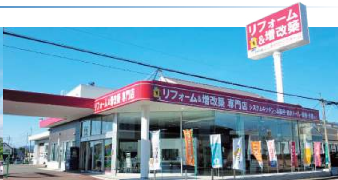
地域密着のスピード対応×施工レベル
